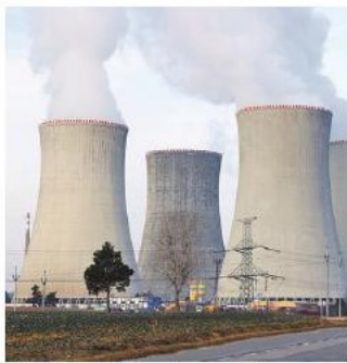
Jaderná elektrárna Dukovany.
